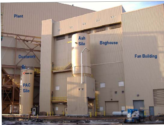
We Energies' Presque Isle Power Plant, Marquette, MI.
